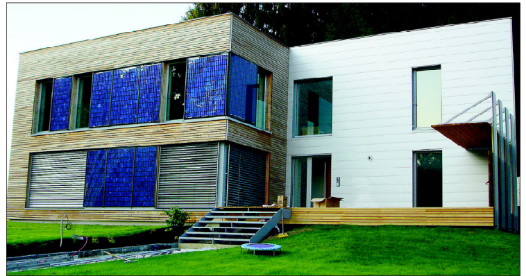
Photovoltaikpaneele anlagen (im Bild an der Fassade) wandeln Sonnenlicht in sauberen elektrischen Strom um. FOTO: ERTEXT SOLAR GMBH
